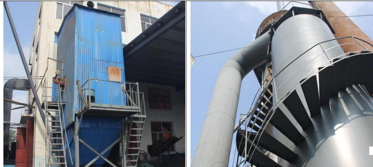
图 4.1-4 (2) 脱硝设施 (左图) 和脱硫塔 (右图)
