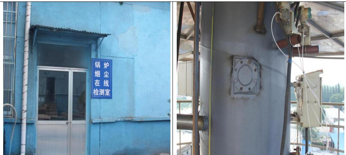
图 4.1-4 (3) 烟气在线监测 (左图) 和取样口 (右图)
